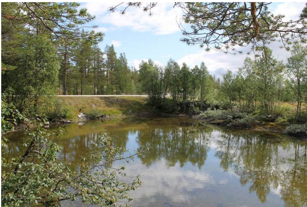
Østre dam. Tilførselsrør ses i vegskråning.
